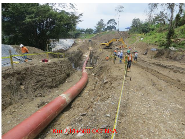
Excavación Alivio de Esfuerzos Km 234+600 5
