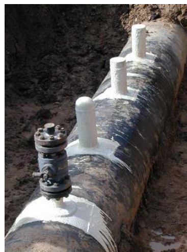
Km 158+150 Válvulas ilícitas condenadas bajo invernadero. Fuente OCENSA 2003
