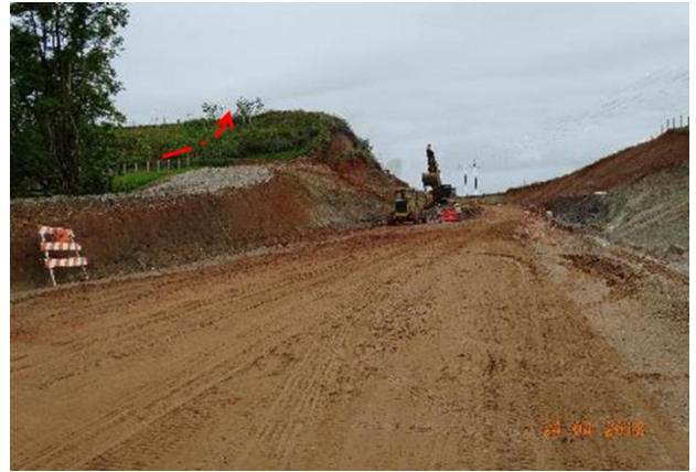
PK 548+100 Rutas del Nordeste, deslizamiento por excavación para ampliación de la vía. Fuente OCENSA
