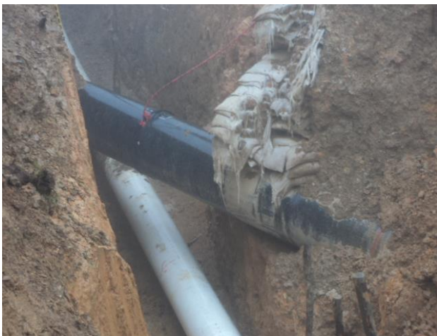
Construcción de Cruce línea Loop de 20" TGI con Ocesa, Fuente OCENSA
