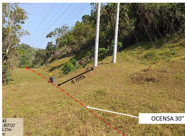
PK 491+700 Instalación de postes de línea de transmisión eléctrica cercana al oleoducto, Fuente OCENSA
