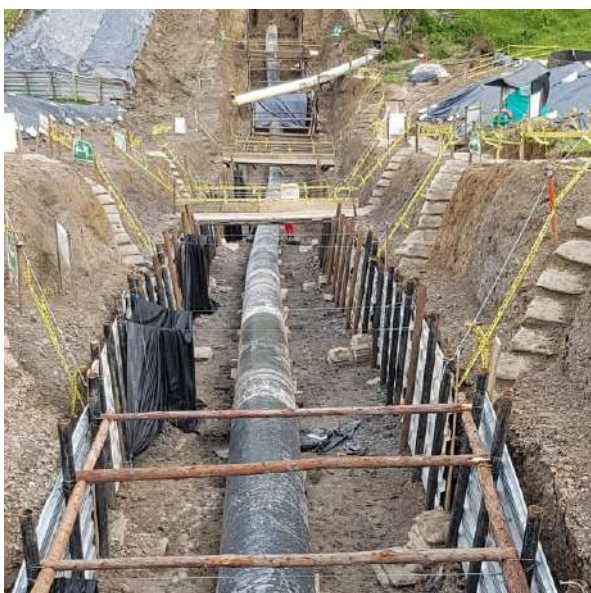
Figura 9. Obras de alivio de tensiones en el DDV OCENSA
