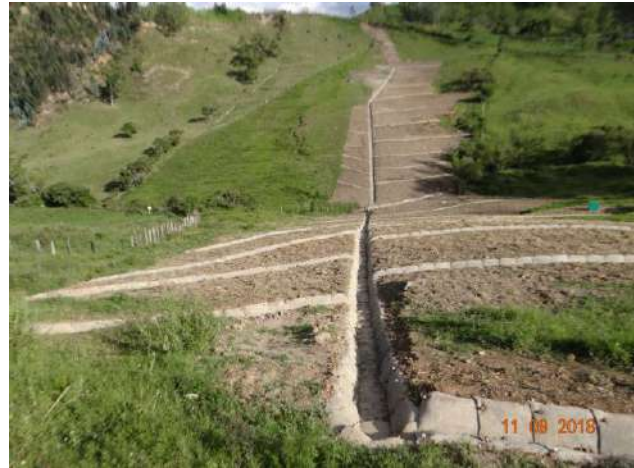
Figura 8. Obras de manejo de aguas en el DDV OCENSA
