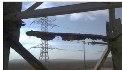
Fig 7. Grado de corrosión III
