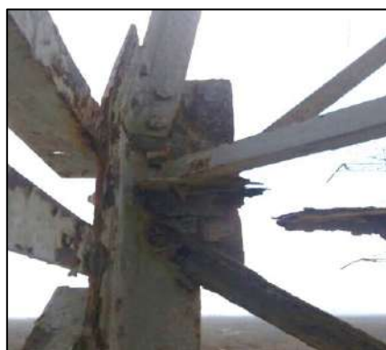
Fig 6. Condición de perfil de columna
