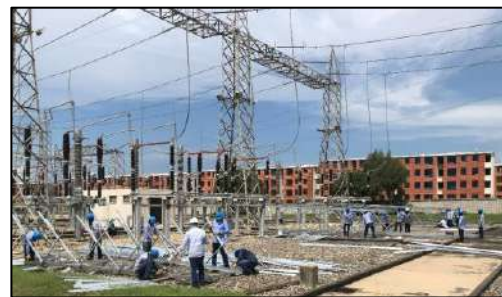
Fig 10. Armado de vigas y estructuras nuevas en piso parte I.
