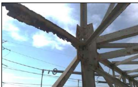
Fig 5. Condición de perfil de viga asociada a pórtico de la subestación NBQ
