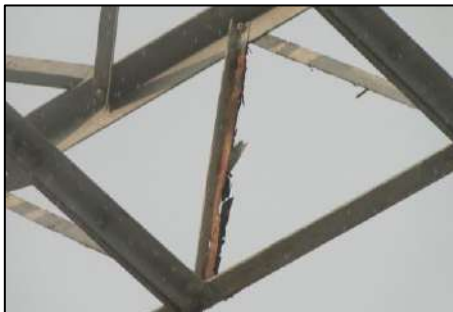
Fig 4. Condición de perfil de viga asociada a pórtico de la subestación NBQ
