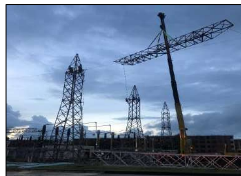
Fig 12. Desmontaje de vigas y estructuras actuales parte I.
