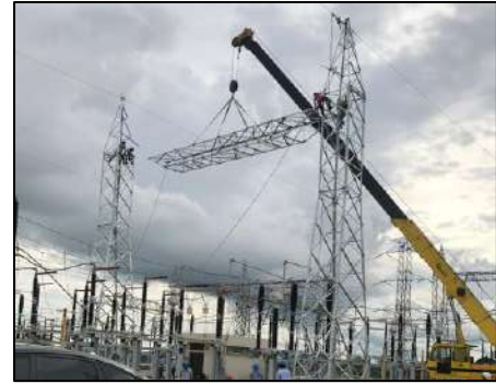
Fig 18. Montaje de estructuras nuevas parte I.
