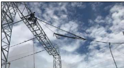
Fig 17. Montaje de Vigas.
