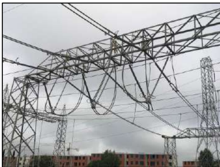
Fig 16. Seccionamiento de Barra 2.
