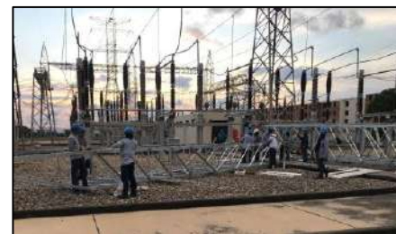
Fig 11. Armado de vigas y estructuras nuevas en piso parte II.
