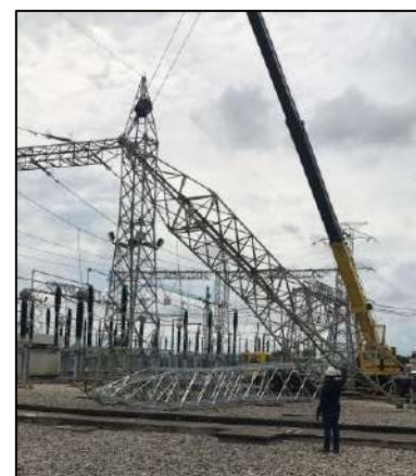
Fig 13. Desmontaje de vigas y estructuras actuales parte II.
