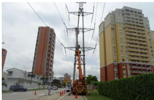
Gráfica 3. Cambio de brazos, riostras, herrajes y aisladores en postes dobles.
