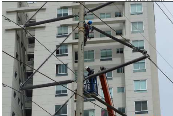
Grafica 2. Cambio de aisladores poliméricos en postes de suspensión.
