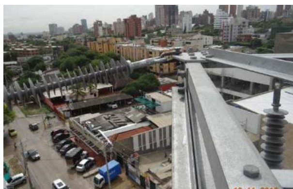
Gráfica 4. Cambio de brazos, riostras, herrajes y aisladores en postes dobles.
