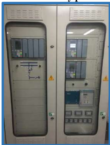
Fig. 3 – Tablero de control y protecciones en una subestación eléctrica de alta tensión [4].
