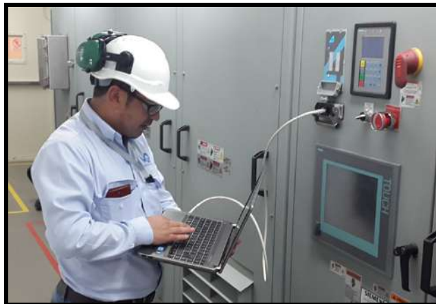
Figura 6. Conexión Local con Software propietario en VFD SIEMENS Robicon 6000HP
