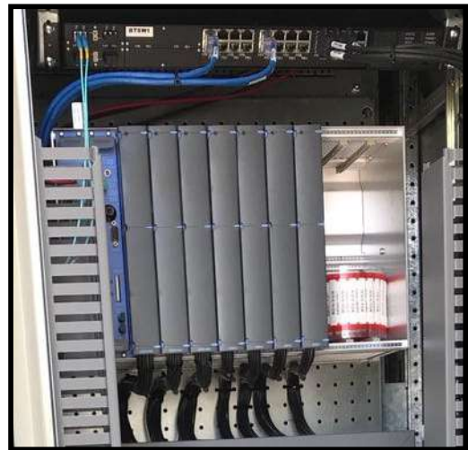
Figura 2. RTU Eléctrica Instalada en Subestación/CCM de 480VAC
