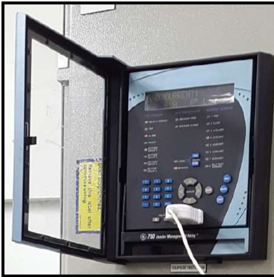
Figura 1. IED de Protección en Celda de Media Tensión 6900Vac
