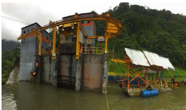
Figura 4. Izq. Instalación de nuevo sistema de almeja anclado a bocatoma. Der. Barcaza, antiguo sistema de almeja.
