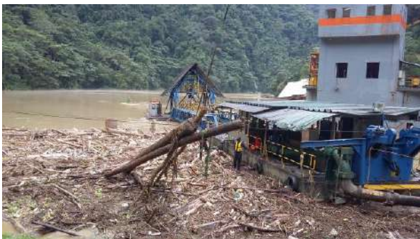
Figura 1. Palizada de creciente súbita en noviembre de 2017, ocasionó: parada de central por una semana, daño en cable de la draga (azul) entre otros.
